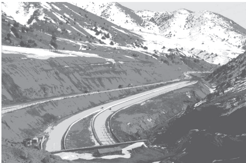
8.2-rasm. A-373 «Toshkent-O‘sh» avtomobil yo‘lining «Rezak» tunnelliga kirish qismi.
